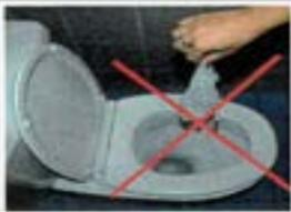
Jetées dans les toilettes, les lingettes s'accumulent dans les canalisations, empêchant progressivement les eaux usées de s'écouler dans les égouts.
