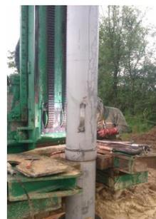
Mise en place des tubes plein en acier inoxydable diamètre 313/323 mm soudés avec centreurs, le 12 mai 2016
