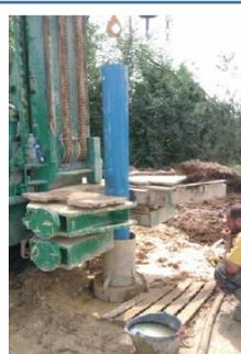
Descente des tubes PVC diamètre 199/225
